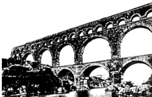
Рис.9. Римский водопровод через реку Гар (Гардский мост)
